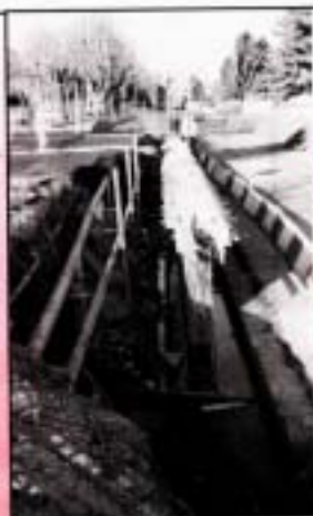
Lavori in Via Torino
