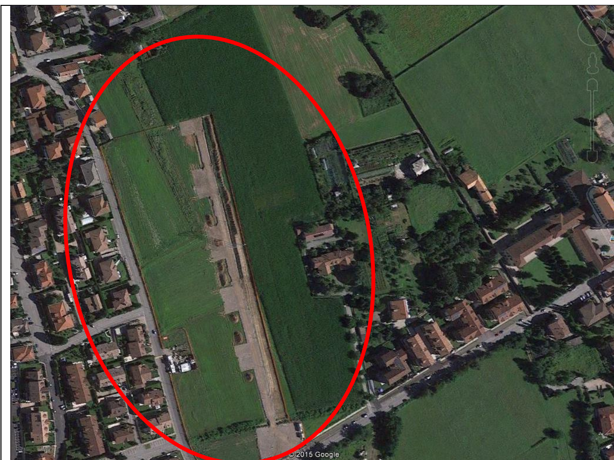
Ambito "San Pancrazio". L'inizio dei lavori di realizzazione della prosecuzione della via La Cassa a congiunzione della via Luigi Firpo, in attuazione del limitrofo PEC C4. (Foto 2014)
