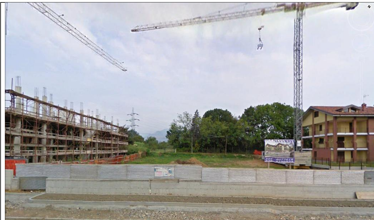
Ambito "San Pancrazio" - Il limitrofo PEC C9 posto lungo la via San Gabriele in fase di attuazione (foto 2012)
